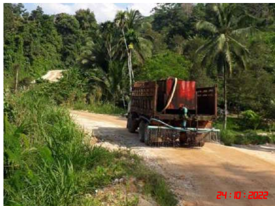
รูปที่ 5 การฉีดพรมน้ำเพื่อลดการพังกระจายของฝุ่นละออง
